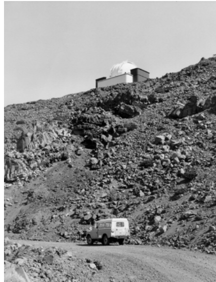
Telescopio INT y carretera de acceso al Roque hacia junio de 1983. También sale fotografiado uno de los transportes habituales del personal del observatorio. Fotografía procedente del archivo del RGO.
